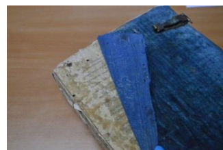
Ilustración 39. Volumen n°24. Pérdida de adhesión del revestimiento
